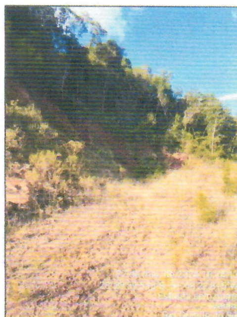
Figura 13: Vista de talude verticalizados e abandono da área.
